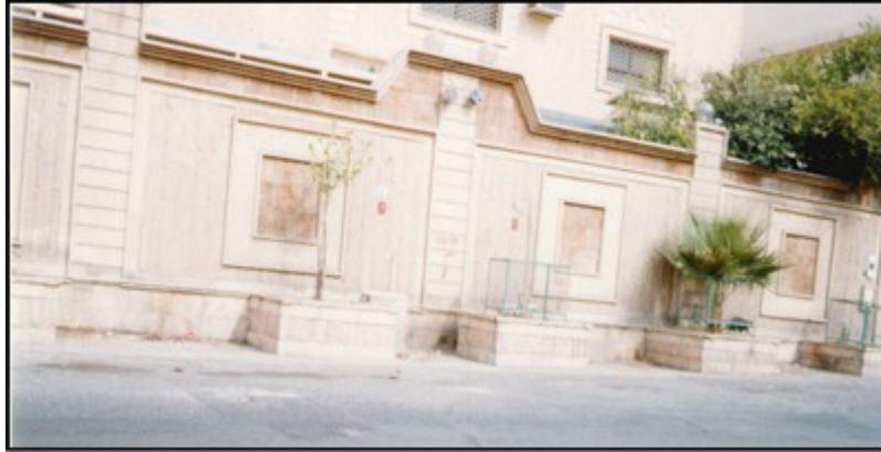
شكل رقم ( 5 ) يوضح الطريقة الخاطئة لزراعة النباتات أمام المنازل وذلك لشغل الأحواض كامل الرصيف وعدم ترك مجال لسير المشاة
