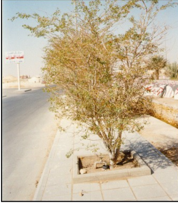
شكل رقم ( 2 ) يوضح الطريقة الخاطئة لزراعة الأرصفة بوضع الأحواض في وسط الرصيف مما يعيق سير المش
