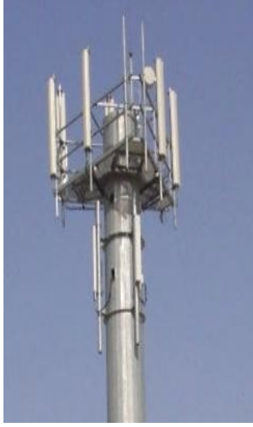
شكل رقم (4) صورة توضح بعض أنواع الهوائيات المثبتة على الأسطح أو الأبراج
